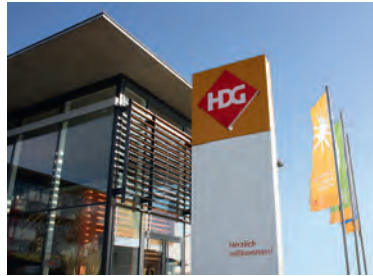
Fertigstellung des Verwaltungsgebäudes
