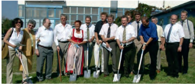
Spatenstich zur Errichtung des neuen HDG Verwaltungsgebäudes
